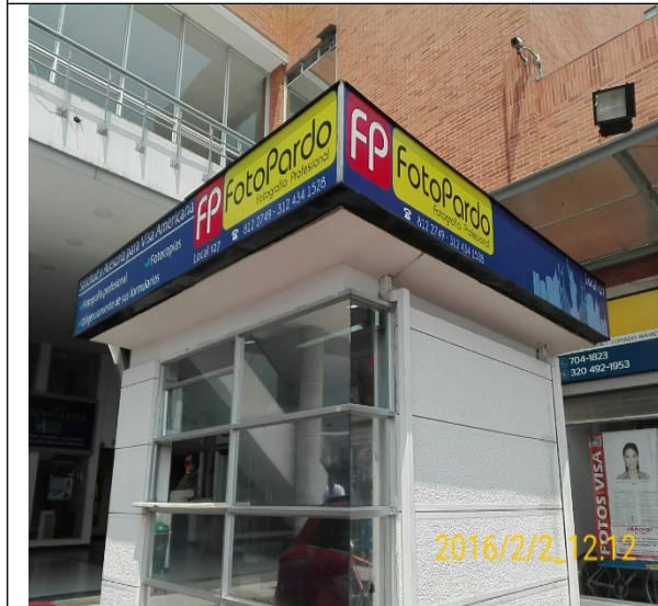
FACHADA DEL ESTABLECIMIENTO
